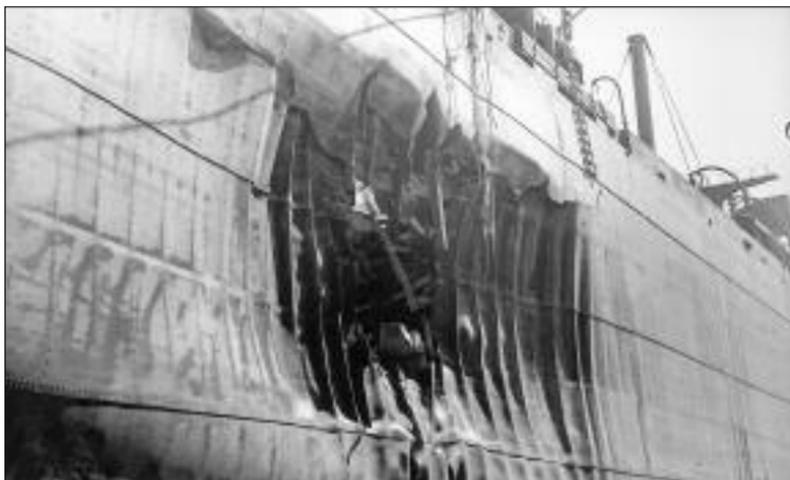
TORPEDO EXPLOSION DAMAGE TO PORT LOWER SIDE OF HULL OF SS *FORT CAMSON*.
